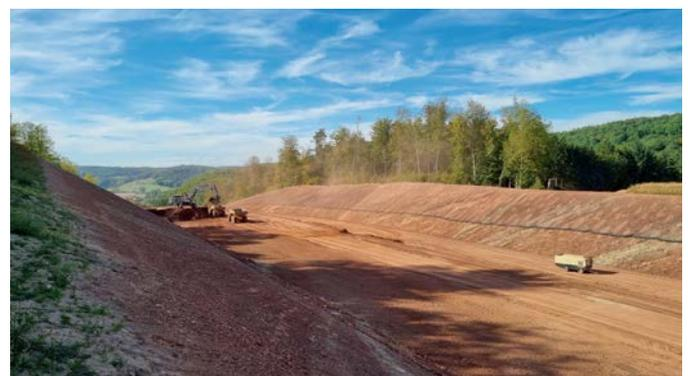
**Bild 8** Böschungssicherung mit doppelt korrosionsgeschützten Bodennägeln, BV A44 Kassel–Herleshausen–Wommener Dreieck
