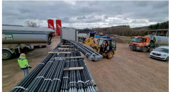
**Bild 2** Doppelt korrosionsgeschützte Tragglieeder auf der Baustelle
