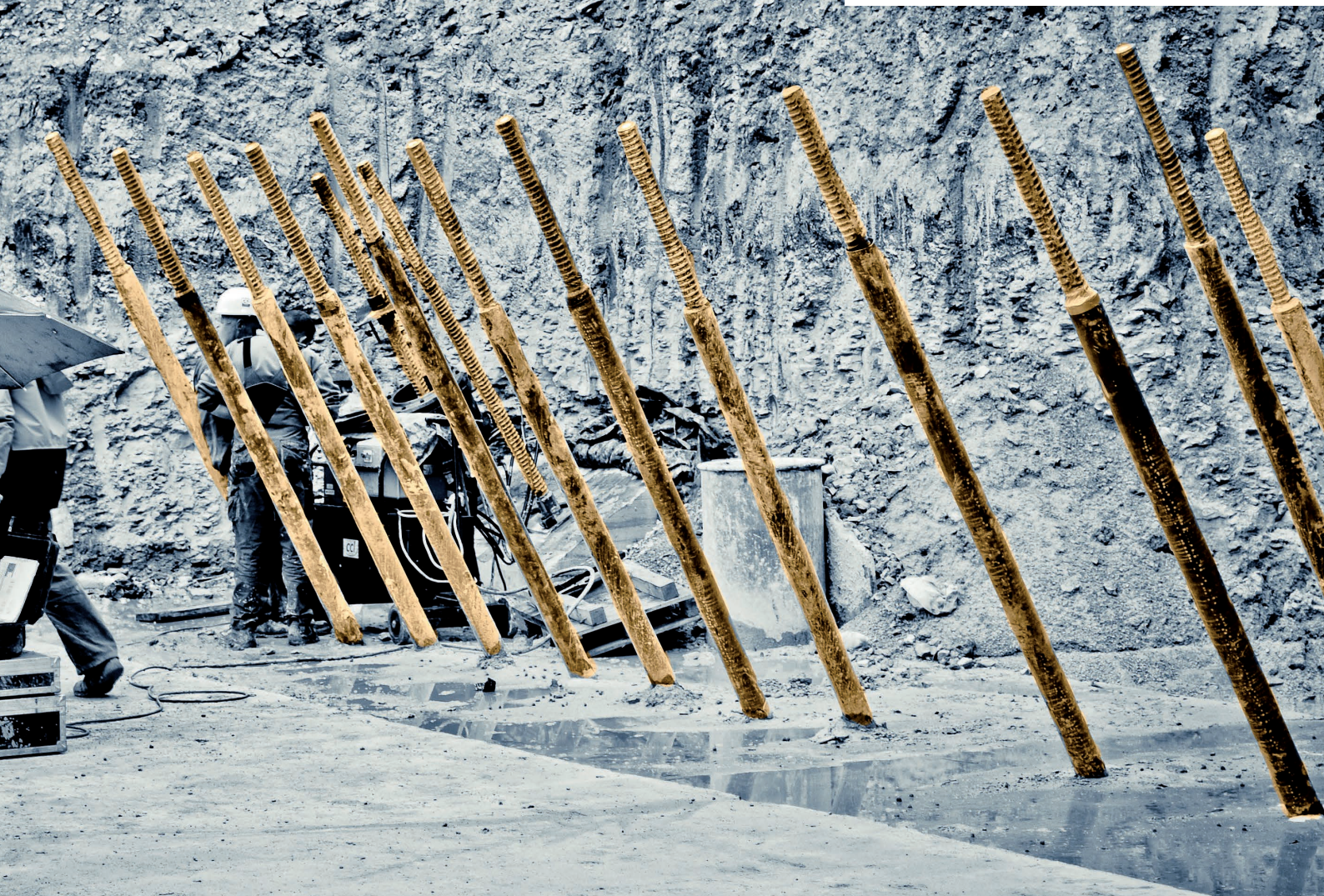
Anclajes para suelo y roca SAS SAS soil and rock anchor
